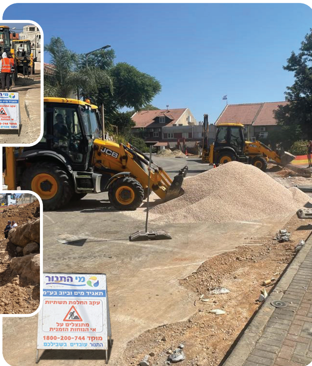
Кацрин, улица Дроп: ремонт сетей водоснабжения и канализации
