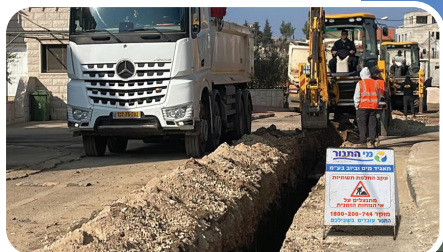
Буката: ремонт канализационных сетей
