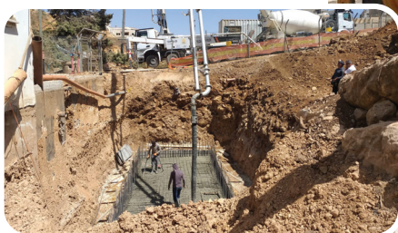
Мас'аде: ремонт оборудования западной насосной станции
