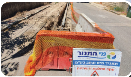
החלפת קו מים ראשי כביש 4 בוקעתא
