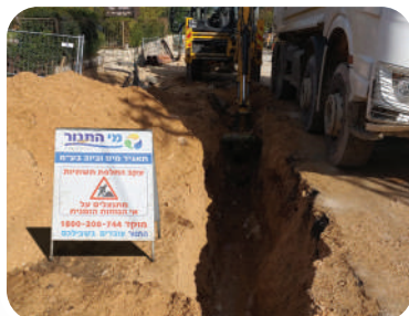
Обновление канализационной инфраструктуры ул. а-Ришоним, Метула
