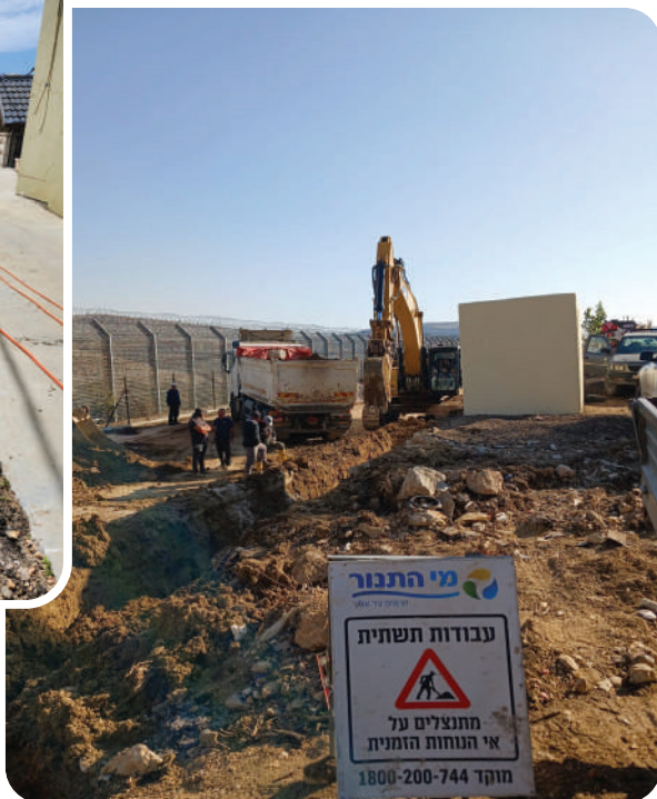
Работы на пограничной дороге – Мадждаль Шамс
