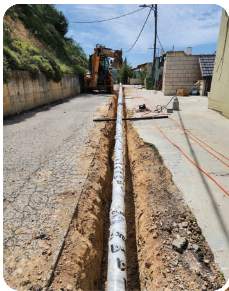
Реконструкция водной инфраструктуры на шоссе 28 Эйн Киния
