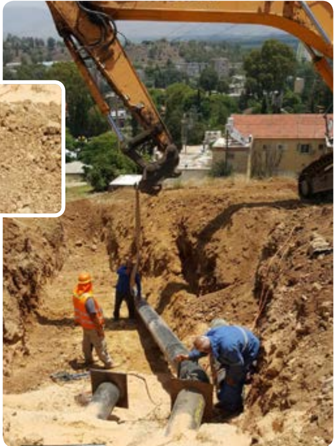
הנחת קו מים לבריכת הישיבה בקריית שמונה.
