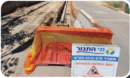
Замена главного водовода на трассе № 4 в Букате
