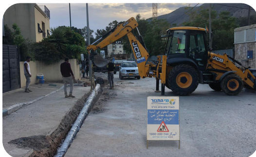
Работы по модернизации системы водоснабжения на улице Трумпельдор в Кирьят-Шмоне
