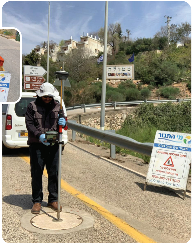
Обследование канализационных люков в Метеле
