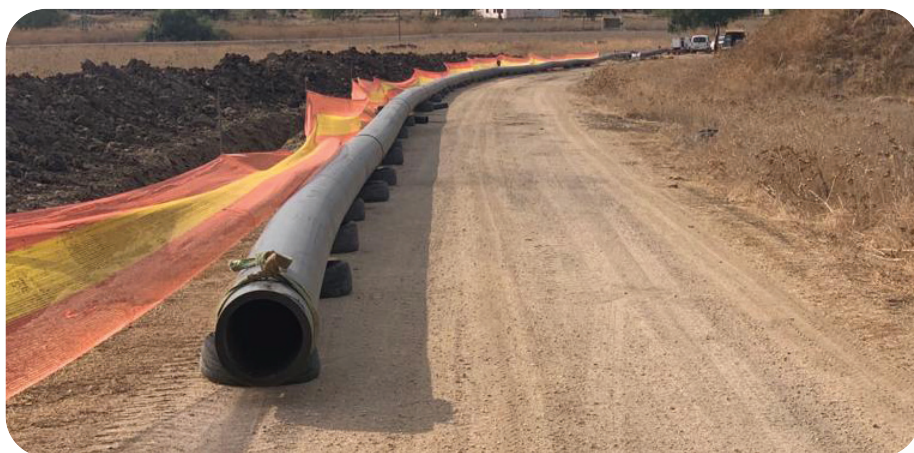
Модернизация канализационного коллектора в Кацрине
